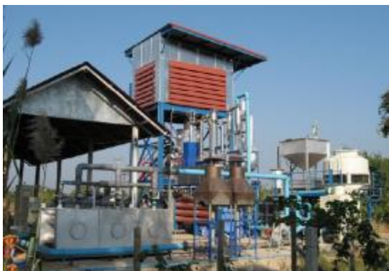
ภาพที่ 4 ตัวอย่างโรงไฟฟ้าชีวมวล กำลังการผลิตขนาดไม่เกิน 1 เมกะวัตต์
